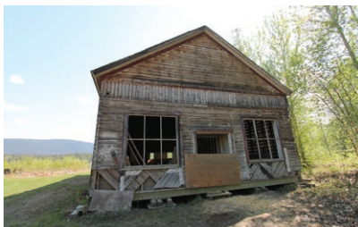
A C Co. Warehouse (ERA, 2015).
